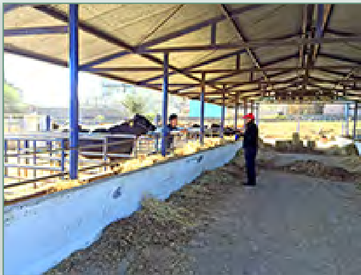
Figura 9.6. Pasillo de tráfico para suministrar alimento en los comederos paralelos.
