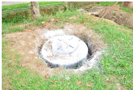
Figura 3.- Se agrega cal por fuera de la fosa y se tapa.
