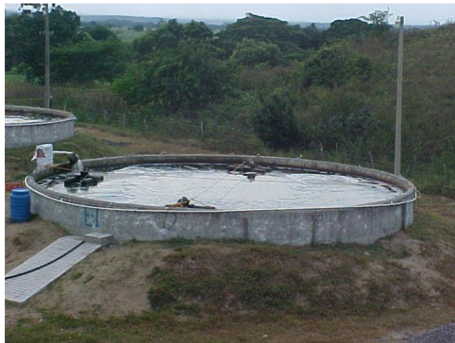
Figura 35. Estanque circular de concreto
