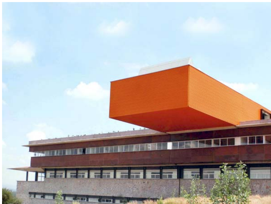
Panorámica de la nueva Unidad Académico-Administrativa del CEIEPAA.
