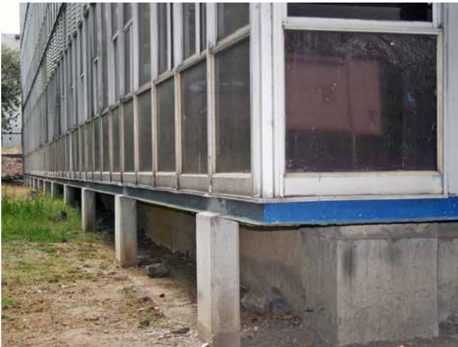
*Parte de los trabajos consistieron en la fabricación de dados de cimentación.*
