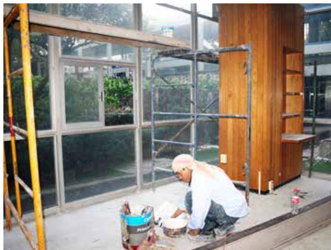
Durante las obras
