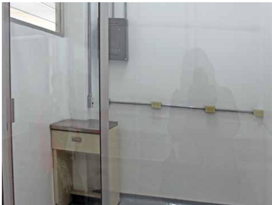
*Instalación eléctrica expuesta para detectar cualquier problema ocasionado por descarga o corto.*
