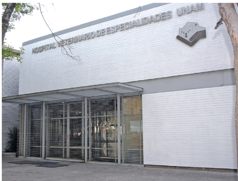
La construcción de nuevas instalaciones para el Hospital Veterinario de Especialidades, uno de los objetivos del proyecto.
